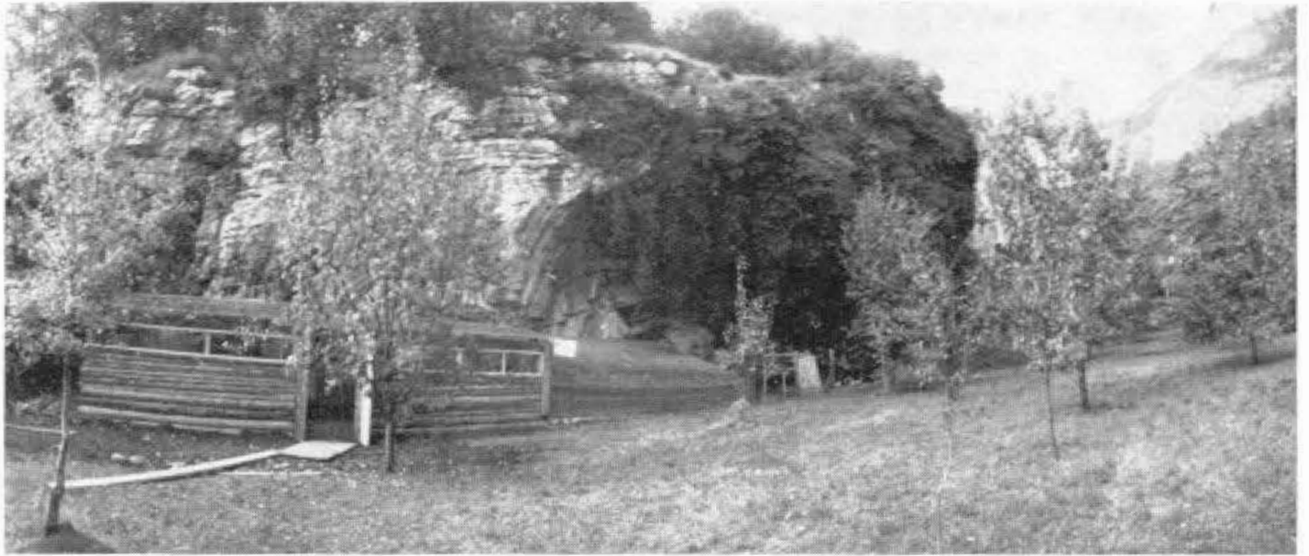
Fig. 19 - Panoramica della zona del riparo durante i lavori.
